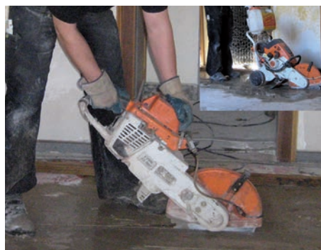
Trennschleifer/Fugenschneider, Benzinmisch bis 12/14 cm Schnitttiefe
